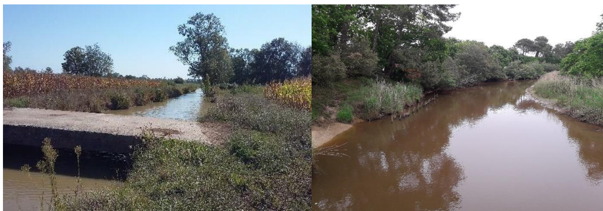
La Maqueline et le Boudigau seront franchis en sous-œuvre* (photo IEA et SCE)
