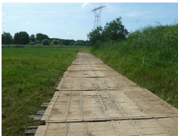
Piste réalisée avec des plaques de répartition de charge
