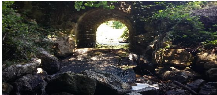
Le Riou Long en assec au droit de son franchissement (photo IEA)
