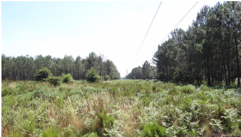
Le couloir de la ligne à l'est du pont du Hourbiel
